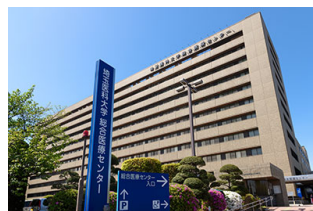
病院外観 本館南側
